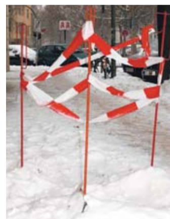
Der Schöneberger Teil der Motzstraße scheint ein gutes Pflaster für wechselnde Dauerbaustellen, deren Sinn sich nicht erschließen. Foto: PM
